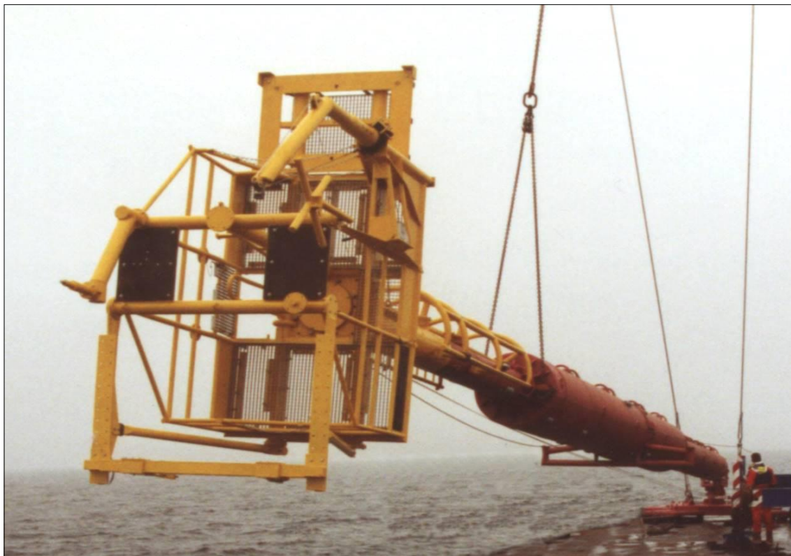
Abb. 25: Ausbringung des Messmastes der 3. Generation durch den BALTIC Taucherei- und Bergungsbetrieb Rostock von einem gemieteten Großponton mit Schwerlastkran am 28. September 2000. Im Hintergrund oben links der alte Messmast der 2. Generation aus dem Jahre 1993 (Fotos: S. KRÜGER/W. ROEDER/M. SOMMER).
