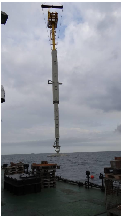
Abb. 28: Beladung und Ausbringung des generalüberholten Messmastes der dritten Generation durch den BALTIC Taucherei- und Bergungsbetrieb von einem dänischen Kranschiff aus sowie seine Erstausrüstung im Juli 2013 (Fotos: S. KRÜGER/W. ROEDER/M. SOMMER).
