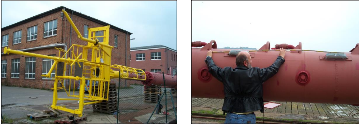
Abb. 23: Endmontage und Vermessungen der dritten Generation des Messmastes im Juni 2000 auf der Pier des BSH in Rostock (Fotos: S. KRÜGER/W. ROEDER/M. SOMMER).
