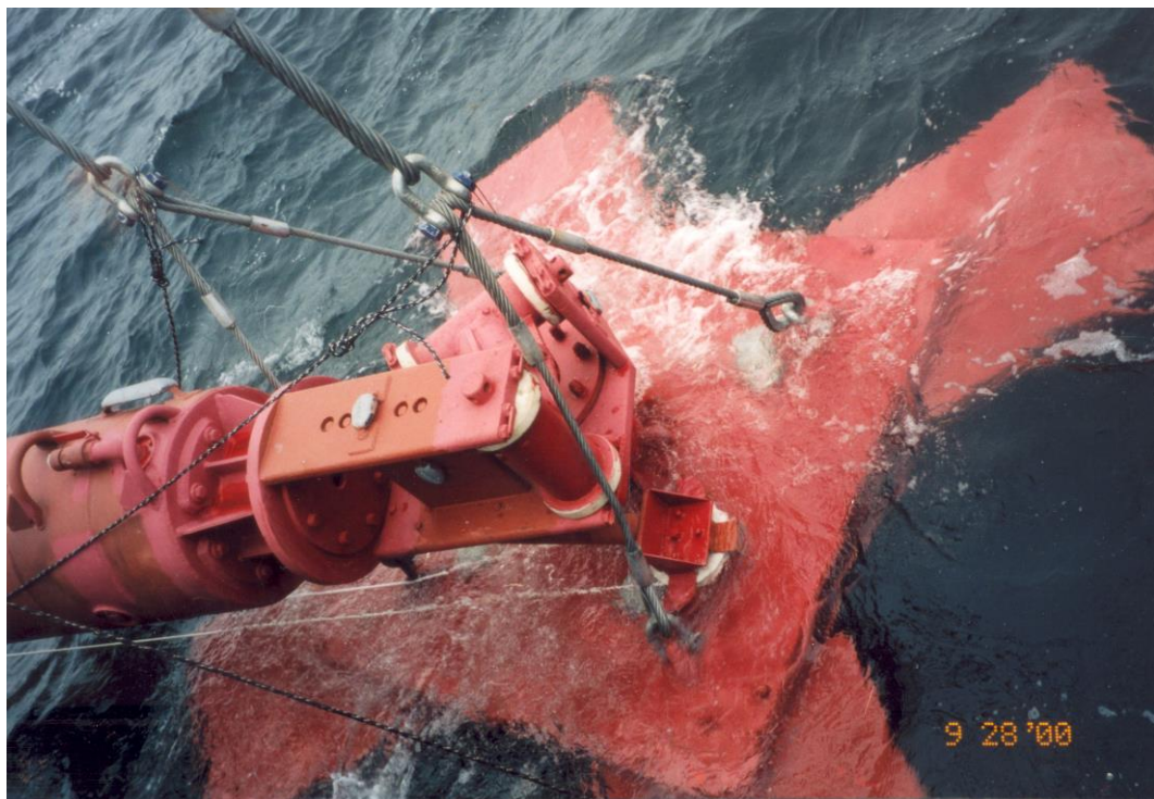
Abb. 22: Mastfuß mit Auslegerplatten (10,7 t; Bleiballast im Standfuß: 4,8 t) und Kreuzgelenk (580 kg) beim Auslegen des Gelenkmastes der 3. Generation am 28. September 2000 (aus IOW-MT 2001).
