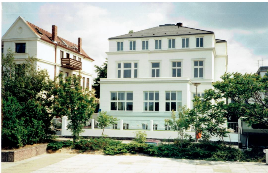
Abb. 4: Die Heinkel-Villa in der Seestraße 15 war mit Mitteln des BMBF renoviert worden und beherbergte im der unteren Etage den Projektträger PTJ für Meeresforschung, Jülich.
