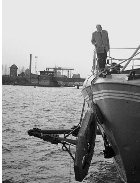
Abb. 22: Vorbereitung des Messmastes auf der Insel Dänholm in Stralsund zur Seerprobung auf dem Schiff „V 84“ des Wissenschaftlich-Technischen Zentrums der Volksmarine in Wolgast. Im Vordergrund: Dr. F. MÖCKEL mit kritischem Blick auf den Mastfuß mit Kreuzgelenk (Foto: H. SEEHASE).
